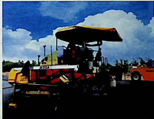
بناء طريق تشانغجي السريع
