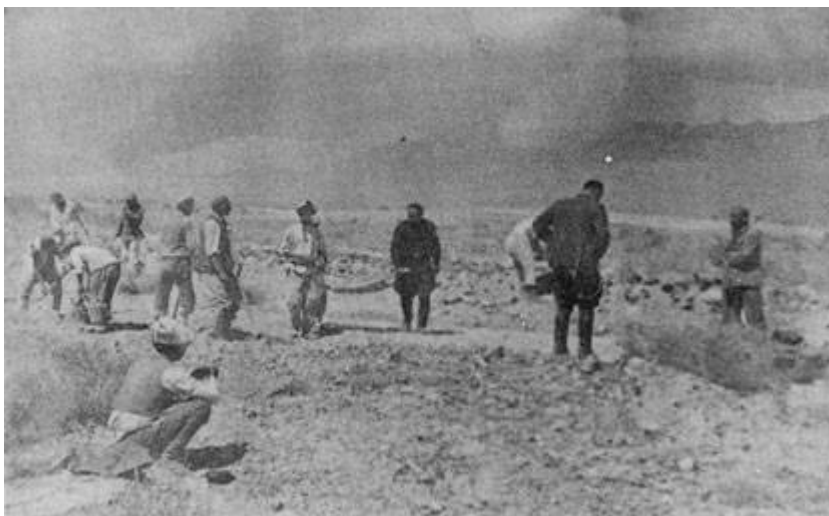
سۇ ئىنشائاتى قۇرۇلۇپ سۇ قۇيۇپ بېرىش
