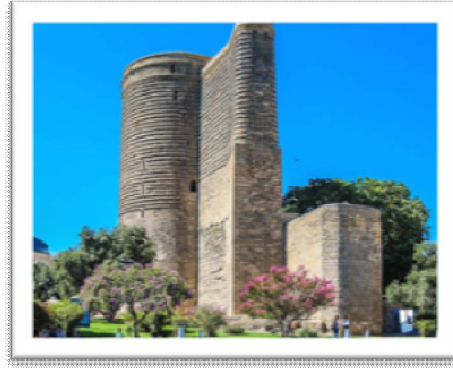
Foto 5 Kız Kulesi restorasyon sonrası.
