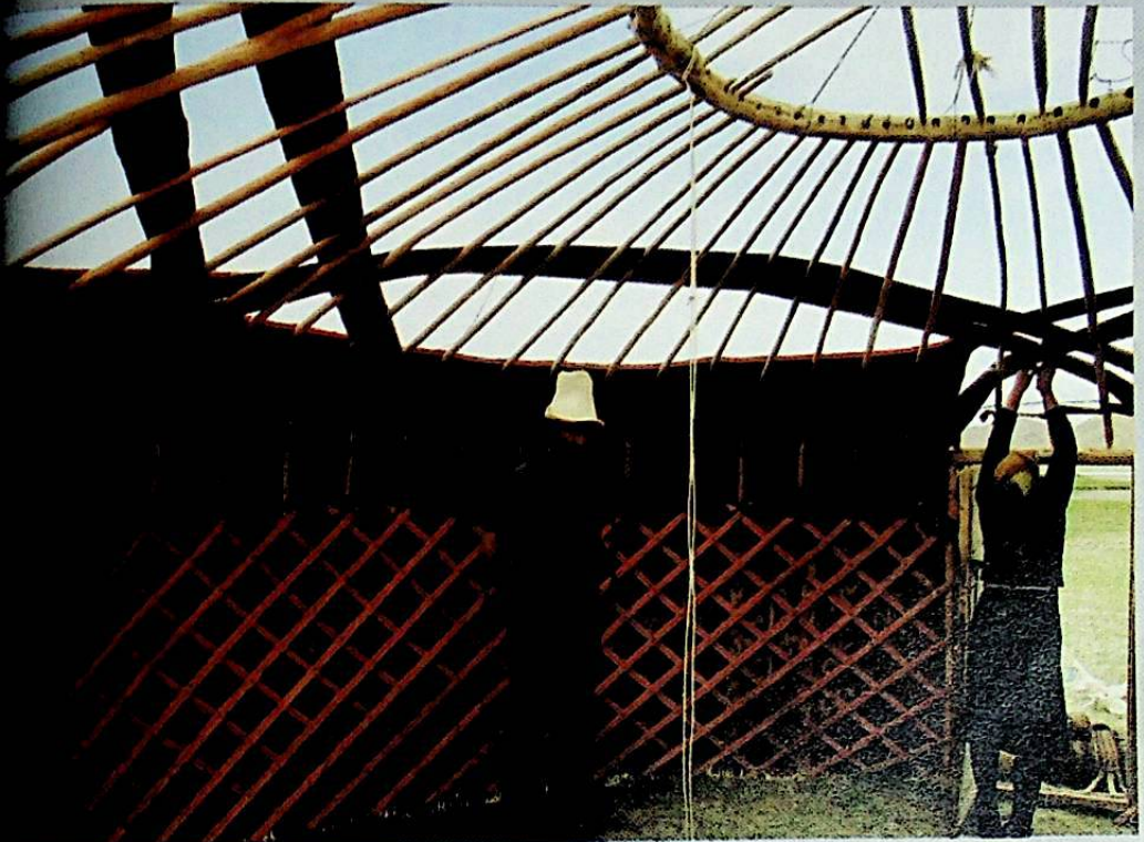
سياج دائري لا يحجب زخارف السجاد لزيئة بصرية داخلية، وسقف ينتهي بدائرة تفتح جلبًا للضوء، وتغلق درءًا للمطر، تلك هي لحظة البناء.
