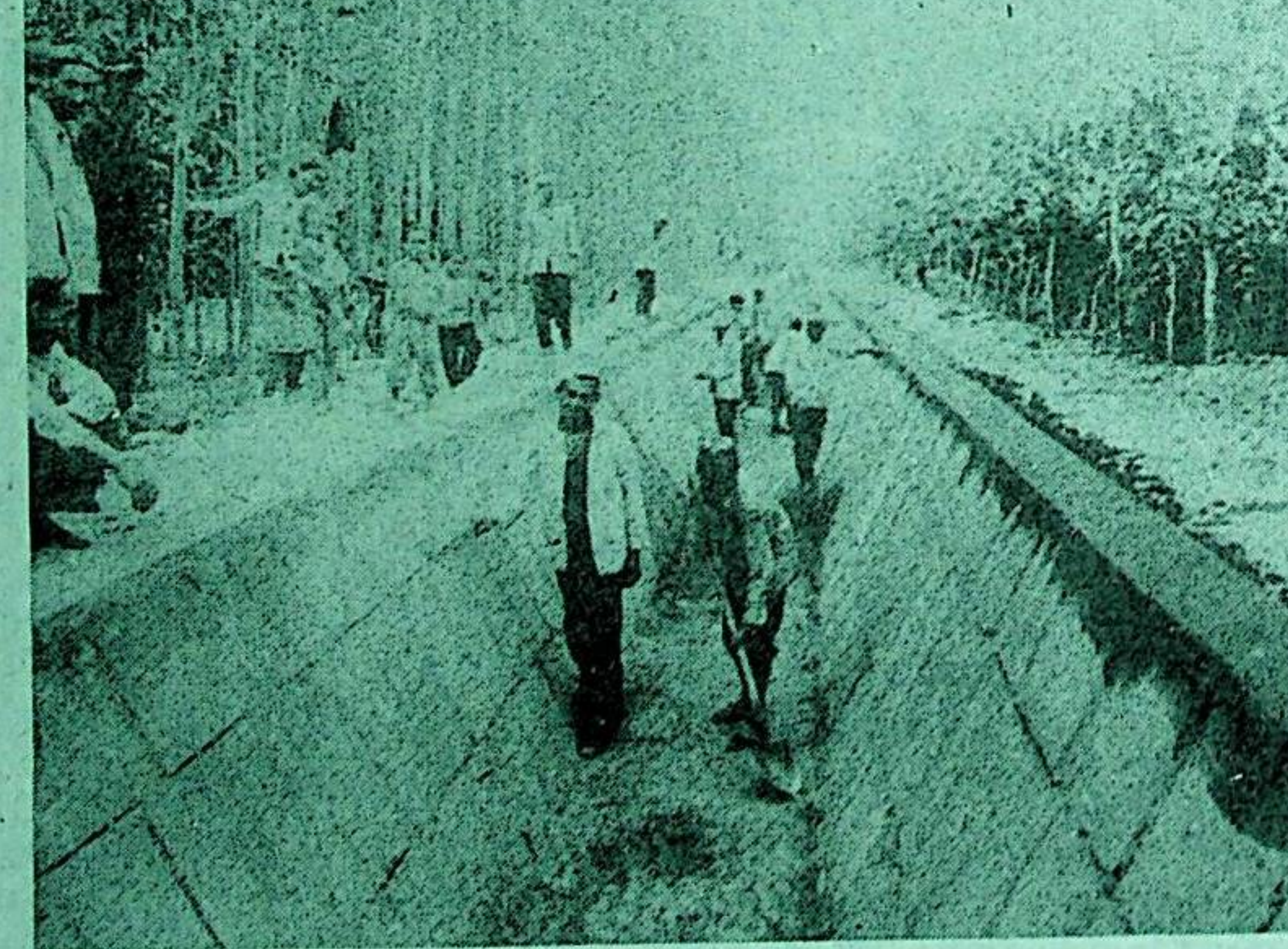
خوتەن ناھىيىسى يېقىنقى يىللاردىن بۇيان سۇ سىڭمىسى ئۈستىگە ياساشنى يىزا ئىگىلىكىنىڭ تەرەققىياتىنى تېزلىتىشتىكى مۇھىم ئىش سۈپىتىدە چىڭ تۇتتى. شياۋ جىپاڭ فوتوسى
