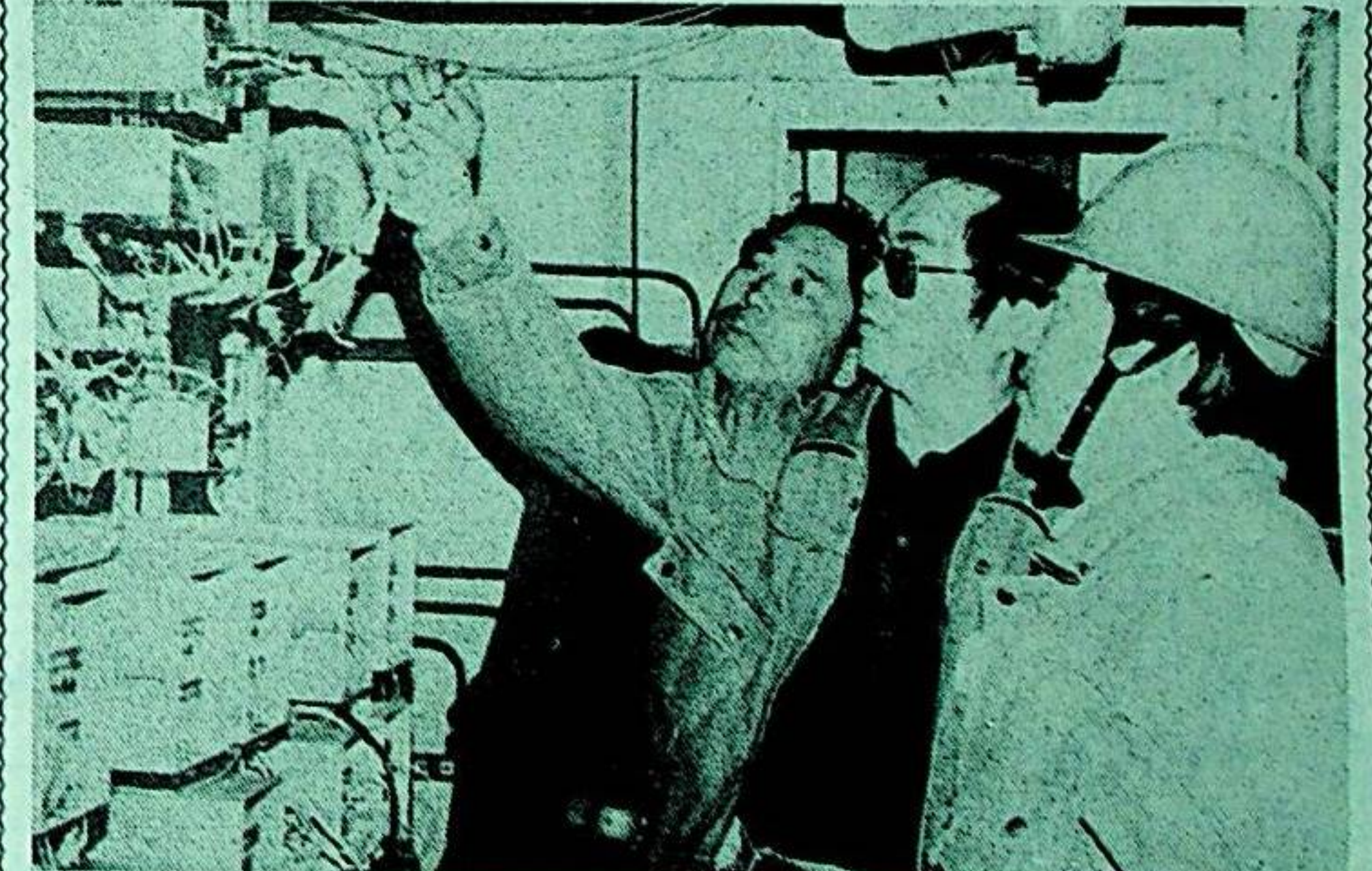
سۈرەتتە: ئىستانسا رەھبەرلىرى بىخەتەرلىك بۆلۈمى ۋە قوغداش بۆلۈمىنىڭ مەسئۇللىرى بىلەن بىللە ئۆسكۈنىلەرنىڭ بىخەتەرلىك ئەھۋالىنى تەكشۈرمەكتە.
