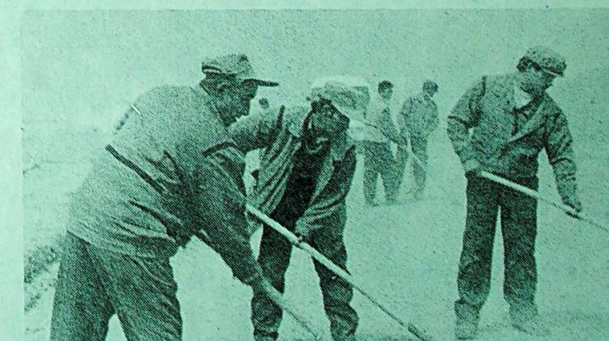
دېڭىز يۈزىدىن 3600 مېتىر ئېگىزلىكتىكى جۇڭگو - قىرغىزىستان چېگرا ئېغىزىغا جايلاشقان ئانۇش تاشيول ئۇچاستىسىنىڭ تورغات داۋىيەنى 33 كىلومېتىر تاشيولنى ياخشى ئاسراپ، ئىككى دۆلەت ئوتتۇرىسىدىكى قاتناشنىڭ راۋانلىقىغا كاپالەتلىك قىلغانغا، ئاپتونوم رايون ۋە قاتناش نازارىتى، تاشيول ئىدارىسى، قىزىلسۇ ئوبلاستى تەرىپىدىن كۆپ قېتىم «ئىلغار يول ئاسراش داۋىيەنى» بولۇپ باھالانىپ مۇكاپاتلاندى. سۈرەتتە: ئىشچىلار يول يۈزىنى تەكشۈرۈشكە.
